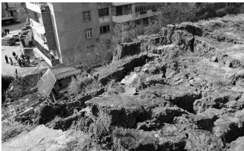
Рис. 2. Оползень в Хатаинском районе г. Баку (фото — 3 марта 2012 г.)
