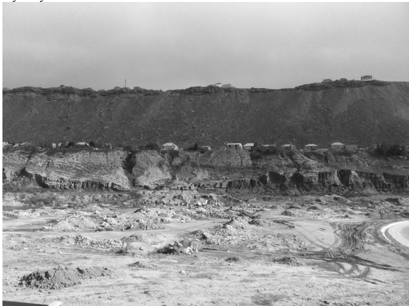
Рис. 3 Овражная эрозия в районе населенного пункта Ени-Ясамал г. Баку (фото — 10 ноября 2014 г.)
